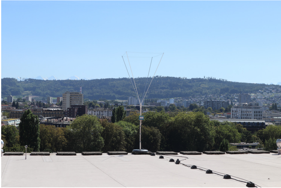
FIGURE 2 – Système de réception placé sur le toit de la Halle de gymnastique du Gymnase des Alpes à Bienne. Un préamplificateur est placé directement sur le mât de l'antenne pour gagner en qualité de signal.
